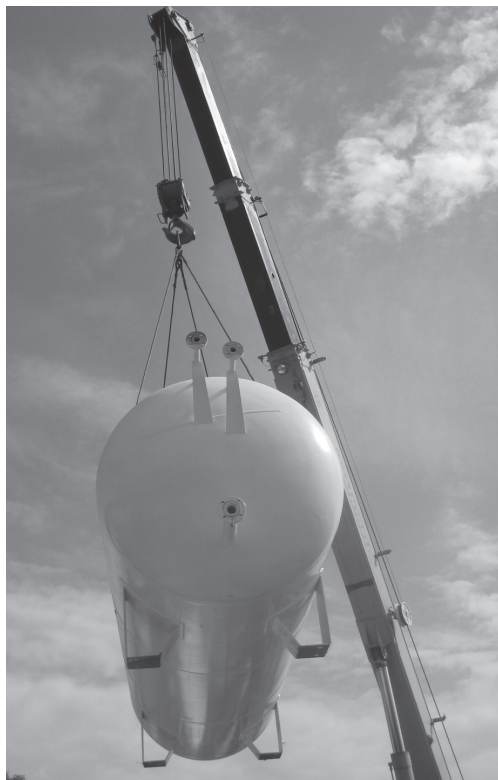
Погрузка наземной емкости для СУГ V-10 м 3 производства «Газовик-Химмаш»
